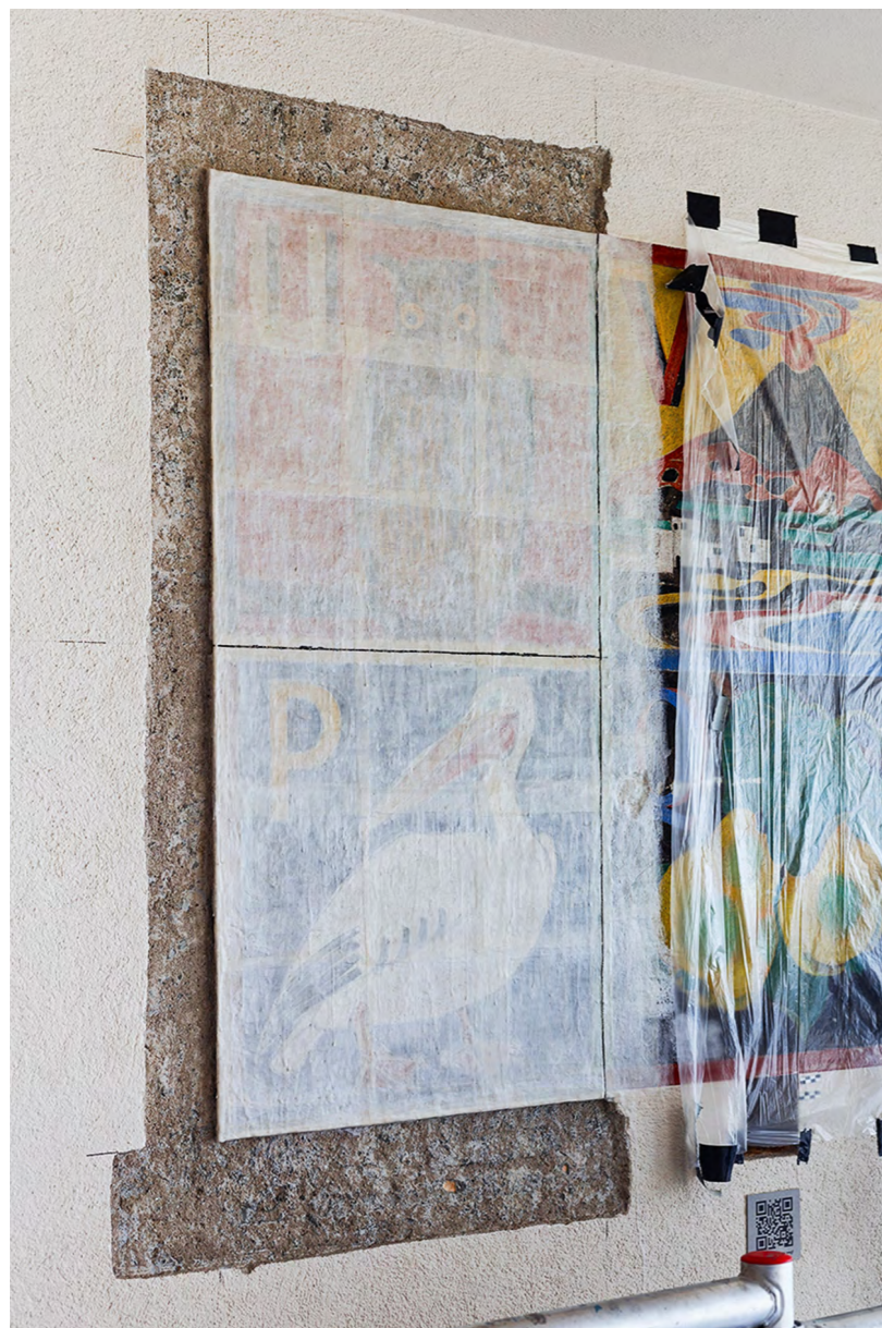
Abb. 6: Bildfelder U und P mit aufliegendem Facing und Reduzierung des umgebenden Wandverputzes fürs Anlegen der Säge. © Alicia Ledergerber
