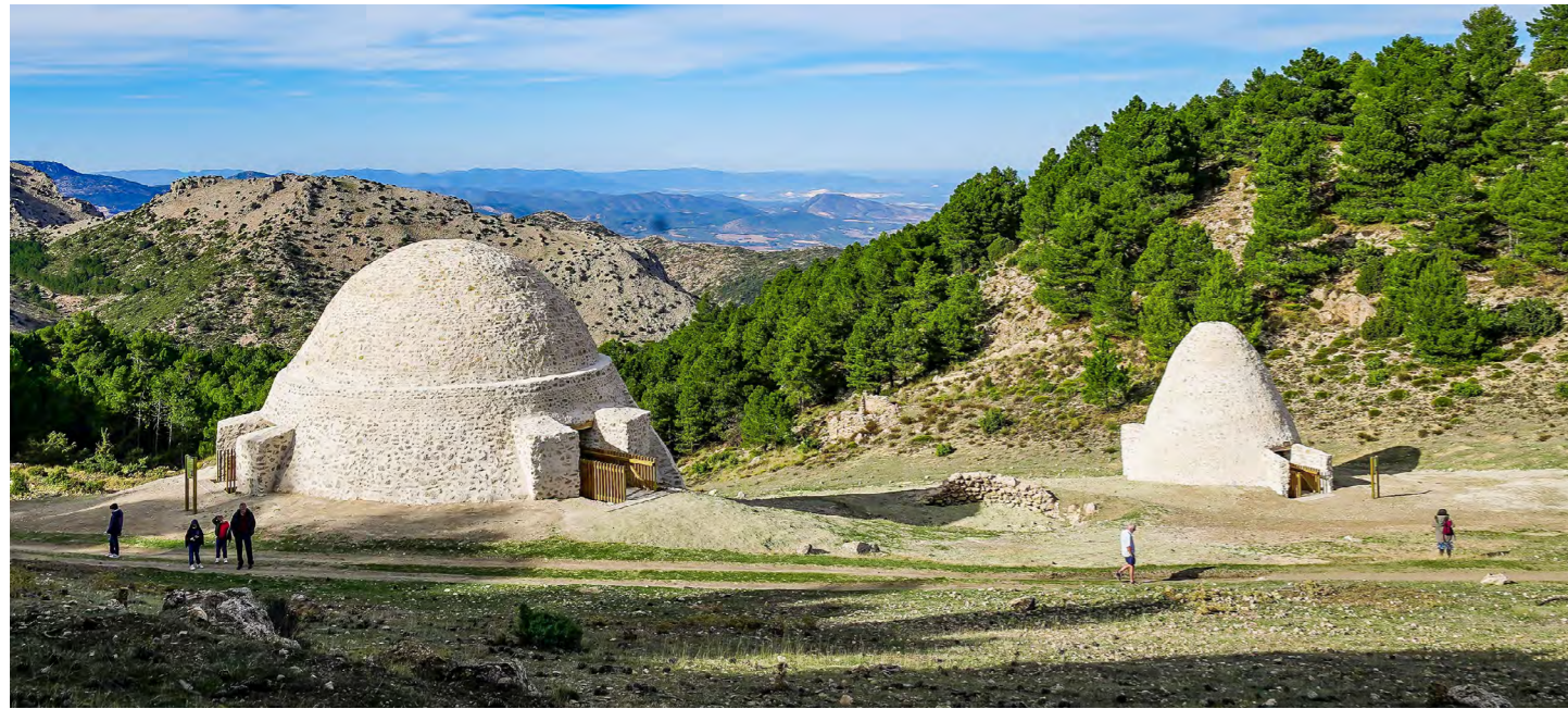
Die Erhaltung der Schneeburgen in der spanischen Gebirgsregion Sierra Espuña wurde 2024 ausgezeichnet. Die Kuppeln aus dem 16. Jahrhundert dienten als Eisfabriken, in denen im Winter Schnee für die Eisproduktion im Sommer gelagert wurde. © Juan Miguel Galera
