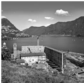
Il cantiere Nuovo Centro Culturale. L'edificio allungato è il vecchio convento.
