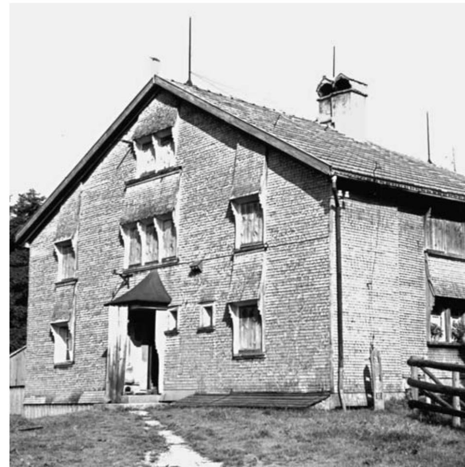
Wandverkleidungen aus Brettern oder Schindeln bilden nicht nur Witterungsschutz und Isolation, sondern sie strukturieren und verfeinern auch die Oberflächen von Konstruktionshölzern. Bild: Teufen (AR).
